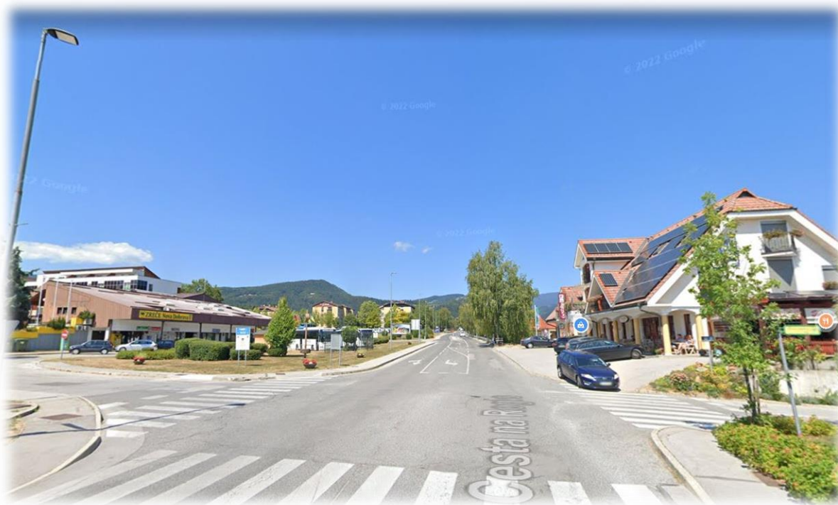
TOČKA 11: Izrazito slaba vidljivost v temi. Na desni strani prehoda ni luči.
