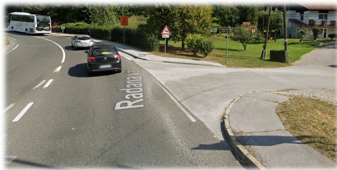
TOČKA 34:. Previdno. Ni označenega prehoda za pešce.
